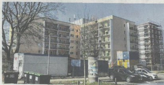
Der Südflügel (links) wird als nächstes Platte für Platte abgetragen.
